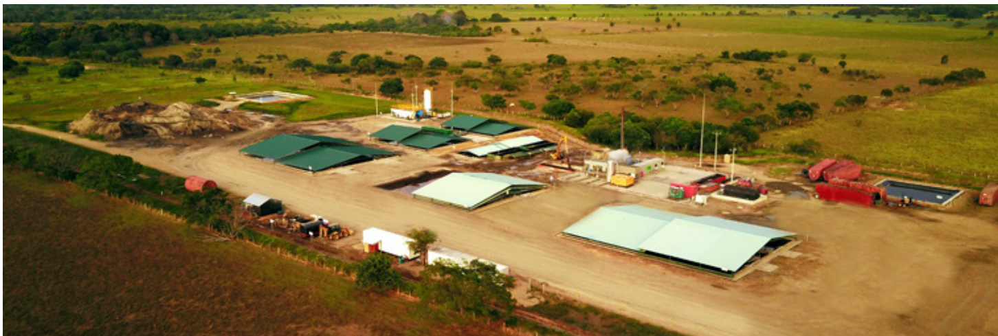
Figura 6. Planta de tratamiento de residuos peligrosos – TECECOR – Aguazul, Casanare – Colombia.
